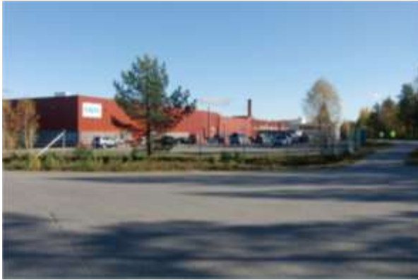
Hydro Extrusion Norway AS' anlegg med bedriftens vestre innkjøring foran.
