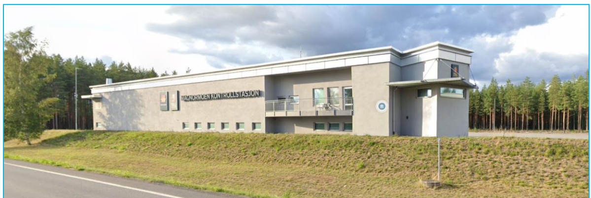
Figur 16: Magnormoen kontrollstasjon. Hentet fra google street view.
