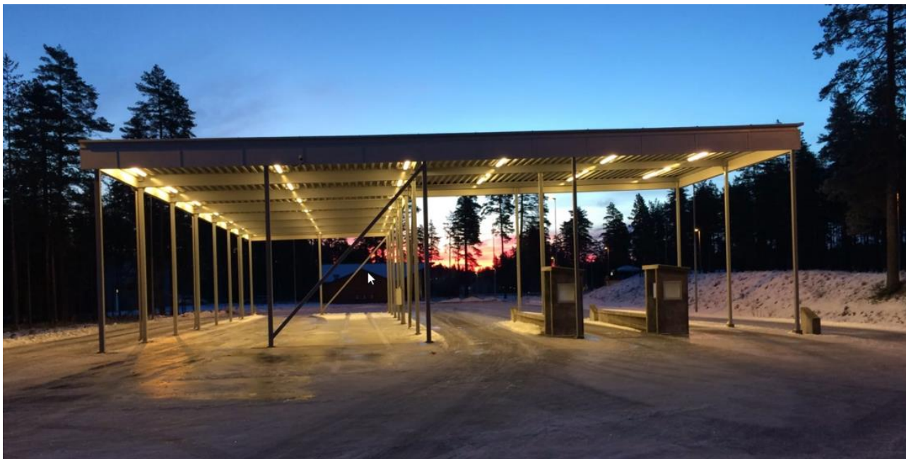
Figur 3-1: Bilde av filterbygget tatt av Tolletaten
