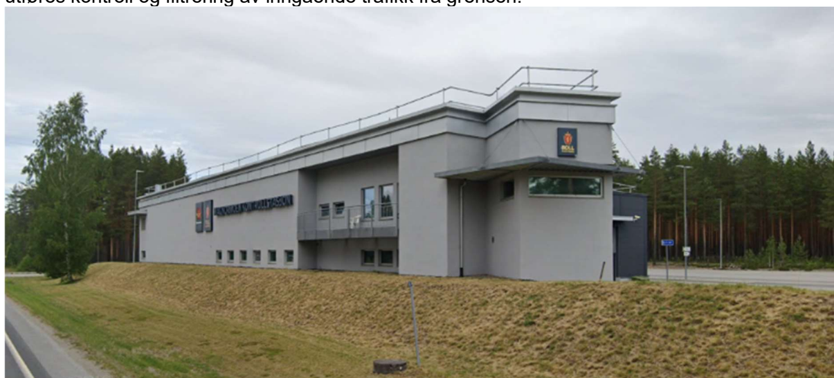
Figur 6: Eksisterende tollbygning. Kilde: Google maps.
